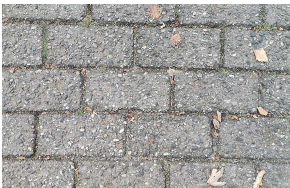
Figuur 1. Het wegdek van Griffiersveld voor de wegreconstructie.
