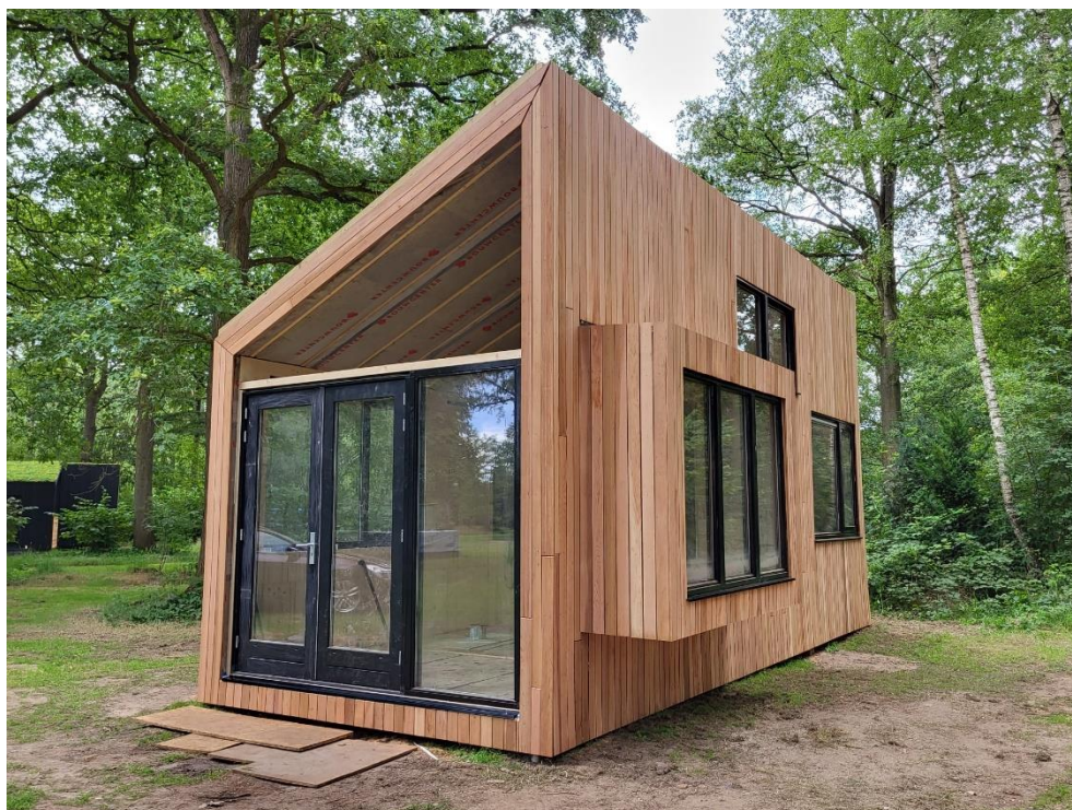
Figuur 14: Door studenten is een circulaire tiny cabin ontworpen en gebouwd in Diepenheim.
