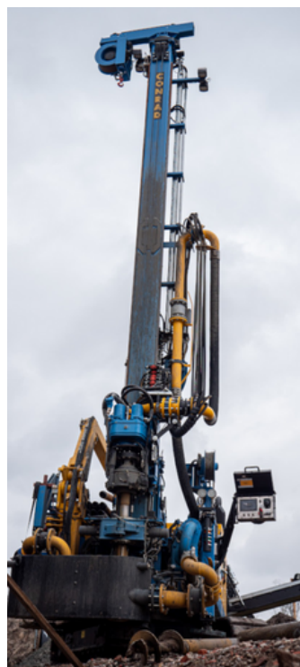
Verticaal boorwerktuig waarmee ondergronds gewerkt wordt.
