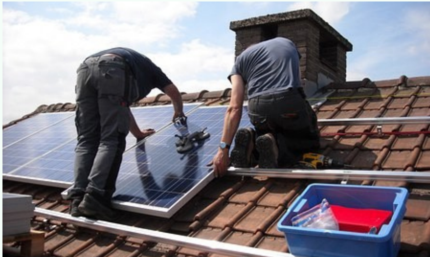
Een foto van het plaatsen van de PVT zonnepanelen.
